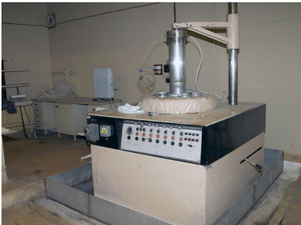
Рисунок 3 – Зд. 500 (пом. 146). Установка РХМ-γ-20
