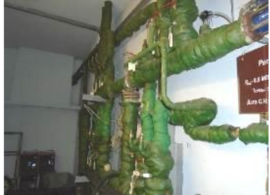
Узел учёта и регулирования тепловой энергии здания №2 РСЦ
