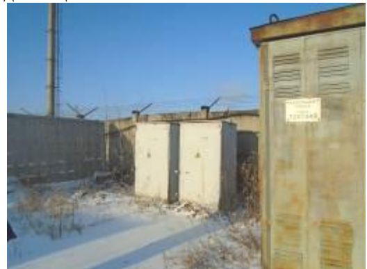
Трансформаторная подстанция; подстанция КТПН-72М 400/6
