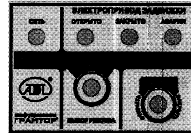
Шкаф управления ГРАНТОР АЭП40-001-54-113(0,63-1А) для электропривода AUMA NORM SG 04.3 задвижки в системе пожаротушения
