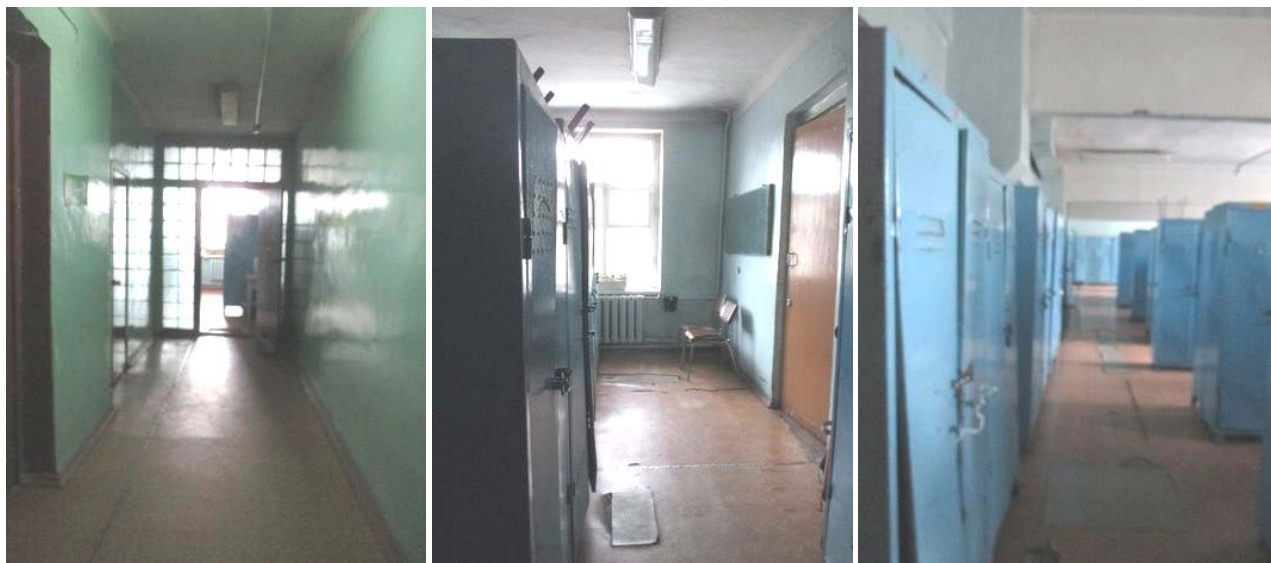
СОЕДИНИТЕЛЬНАЯ ГАЛЕРЕЯ ЗДАНИЙ №1 и 5, инв.№ 7208093
