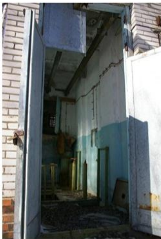
Вход в здание на 1 этаж
