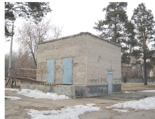
Газораспределительный пункт со складом баллонов профилактория
