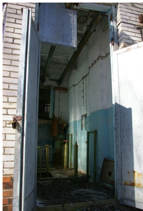
Вход в здание на 1 этаж
