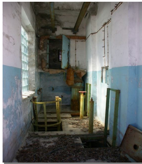
Вход в помещение
