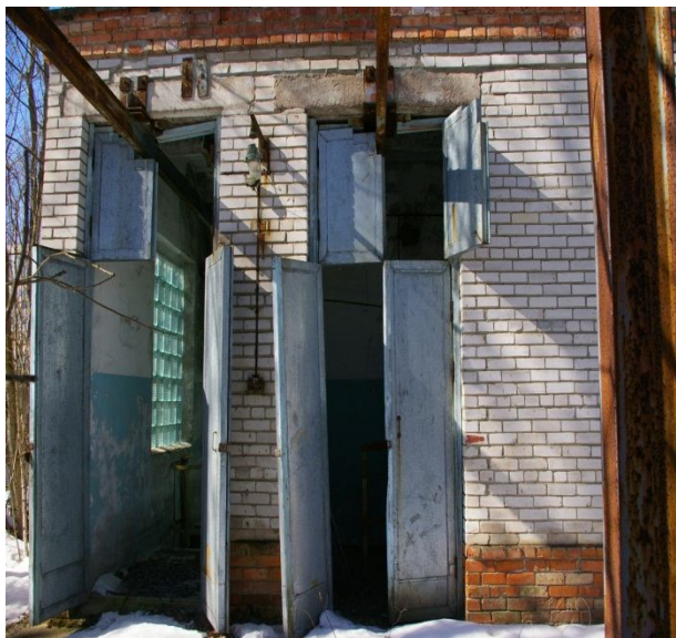
Вход в помещение
