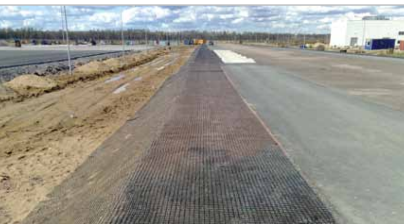
Применение двухосной георешётки ГЕО ДС® при строительстве площадок под высокие нагрузки
