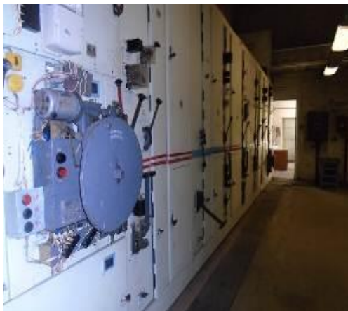
КОМПЛЕКТНОЕ РАСПРЕДЕЛИТЕЛЬНОЕ УСТРОЙСТВО 6 КВ НАСОСНОЙ ТПК
