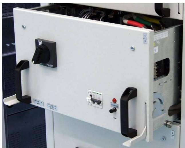
Рисунок 5.10 – Выдвижной блок типа ДТ размера 2М
