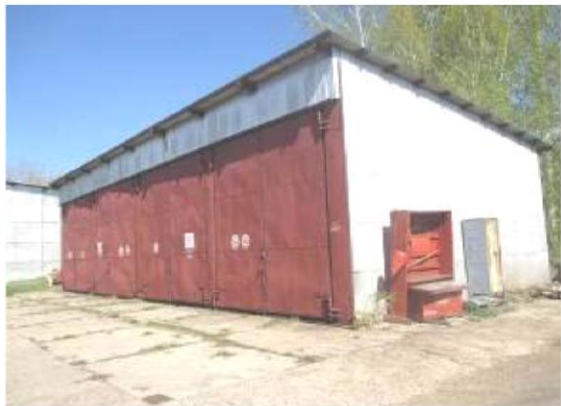
Навес для хранения оконного стекла
