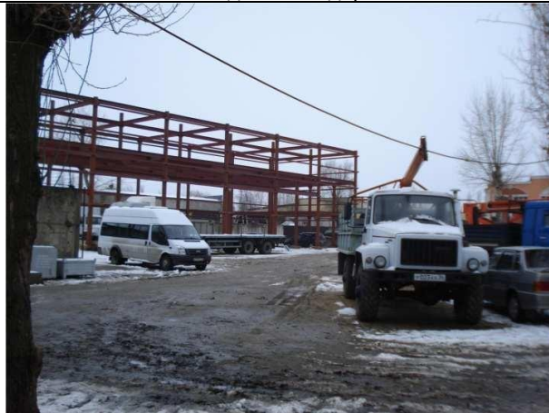
Сооружение – площадка №2 здания-штаб строительства
