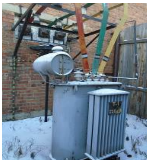
Рисунок 5-6: ТРАНСФОРМАТОРЫ ТМ-250 6/0,4 (2ШТ.)
