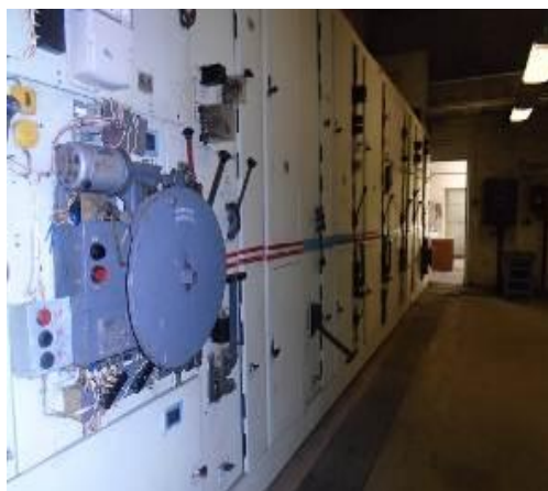
КОМПЛЕКТНОЕ РАСПРЕДЕЛИТЕЛЬНОЕ УСТРОЙСТВО 6 КВ НАСОСНОЙ ТПК
