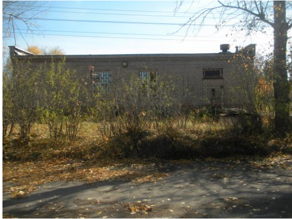
Здание тиристорной техники
