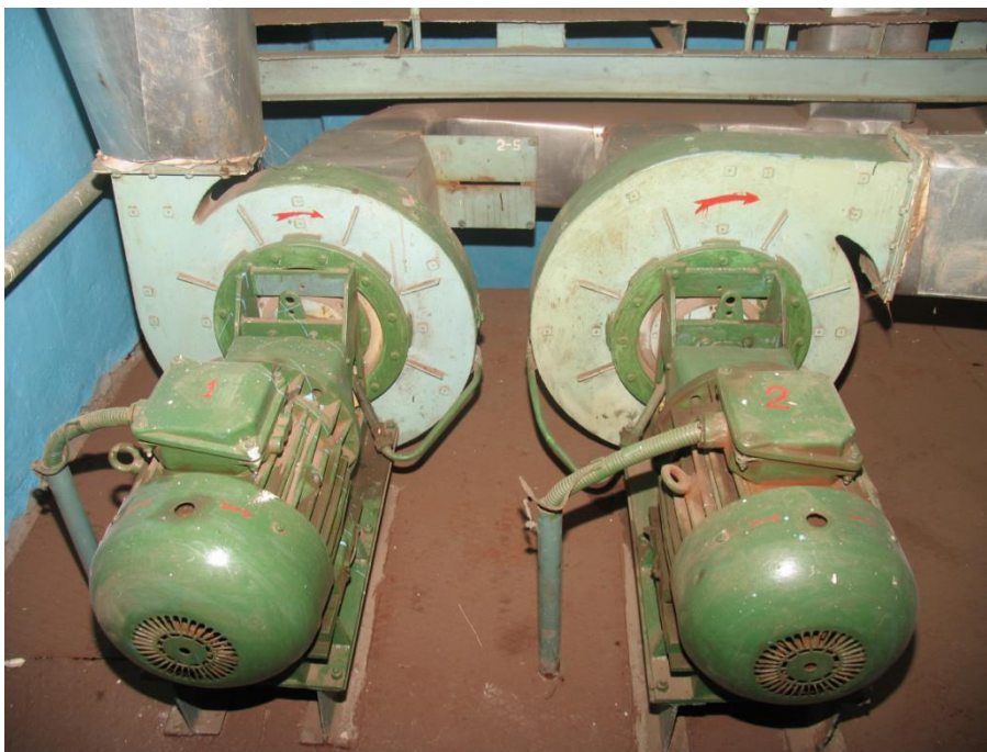
Фото 4 – Вентиляторы теплостойкие ЦСУ-6,1-3
