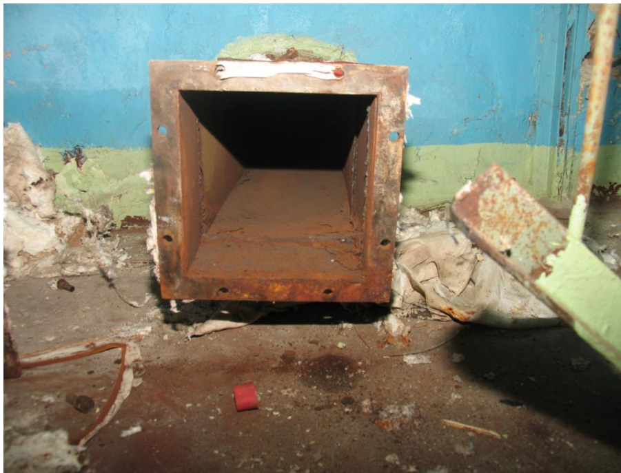
Фото 2 – Воздуховод всасывающий, существующий (состояние внутри)
