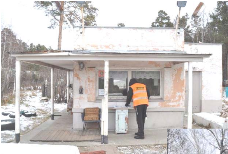
ЗДАНИЕ КПП-5 С ПРИСТРОЙКОЙ АСКРО
