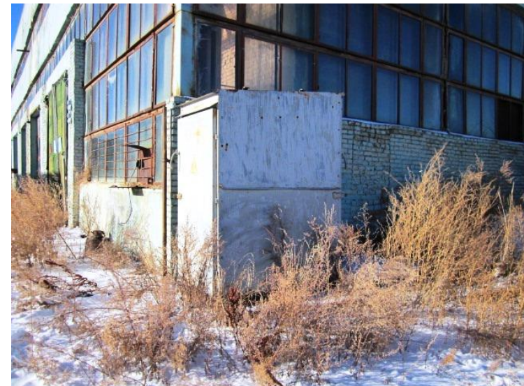
5. Ячейка КСО-366, год выпуска 1981, местоположение – с восточной стороны главного корпуса АРЦ
