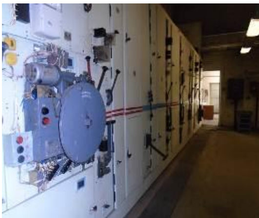
КОМПЛЕКТНОЕ РАСПРЕДЕЛИТЕЛЬНОЕ УСТРОЙСТВО 6 КВ НАСОСНОЙ ТПК
