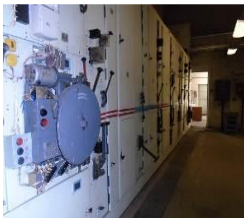
КОМПЛЕКТНОЕ РАСПРЕДЕЛИТЕЛЬНОЕ УСТРОЙСТВО 6 КВ НАСОСНОЙ ТПК
