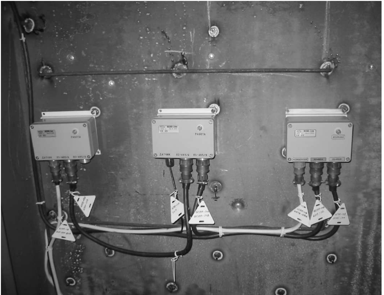
Рисунок 11 - Блоки сопряжения первичного преобразователя производства ООО «НПП «Доза»
